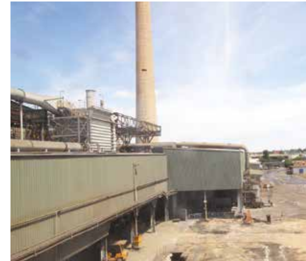
VÓÓR INSTALLATIE VAN DE TSL-SMELTOVEN TE PORT PIRIE (K1 2015)
